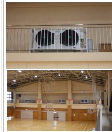
中台中学校体育館_東京都板橋区
