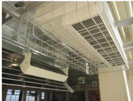
図表A(1):2-2、天吊型対流式空調設備
