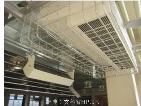
図表A(1):1-2、天吊型対流式空調設備
