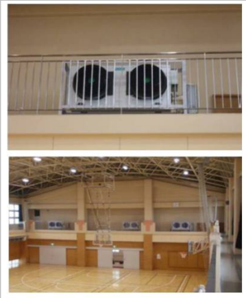
中台中学校体育館_東京都板橋区
