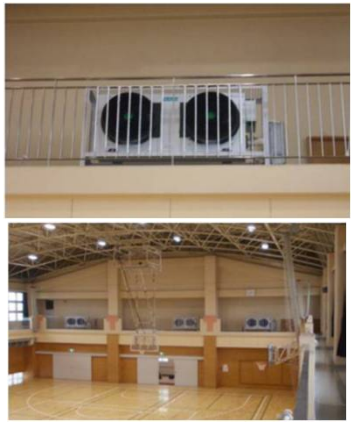
中台中学校体育館_東京都板橋区
